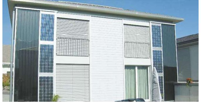
Solaranlage an Fassade
