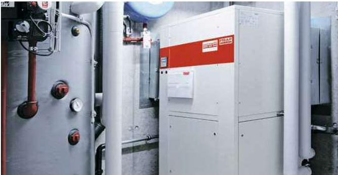
Baubewilligungsfreie Luft/Luft-Wärmepumpe mit Luftbezug im Haus
