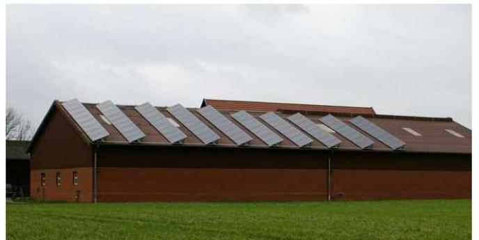
Aufgeständerte Solaranlage (&gt; 20 cm)
