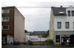
Schliessen von Baulücken
