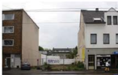
Schliessen von Baulücken
